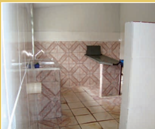
Figura 5 – Impermeabilização das paredes, divisão da área de fabricação com a área de embalagem e armazenamento, retirada de móveis de material não permitido pelo anexo 22.
