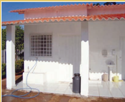
Figura 9 – Construção da queijaria com proteção para chegada do leite, local para higienização dos fabricantes do queijo.
