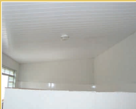
Figura 6 – Colocação de forro no teto.
