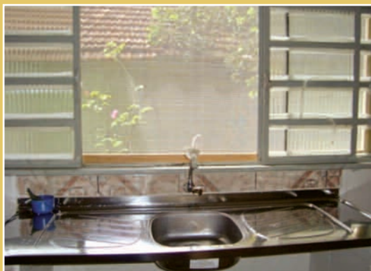
Figura 4 – Colocação de tela nas janelas e troca do material da pia para inox permitido no anexo 22 e retirada dos mofos com impermeabilização das paredes.
