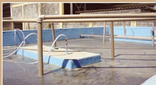
Figura 5 – Efluente de Reator UASB tratando dejetos de suínos.
